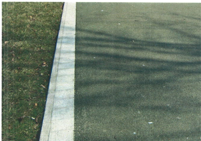
Ryc. 2 Stylizacja nawierzchni z asfaltu barwionego w masie w kolorze szarym
